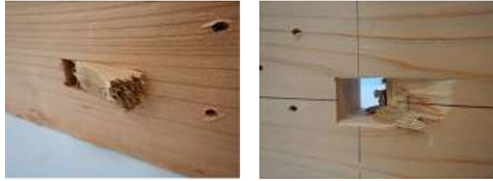
写真16 込栓と雇いの損傷状況
